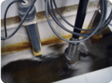
Installation des Spektralsensors (rechts) mit Controller MIQ/TC 2020 XT
