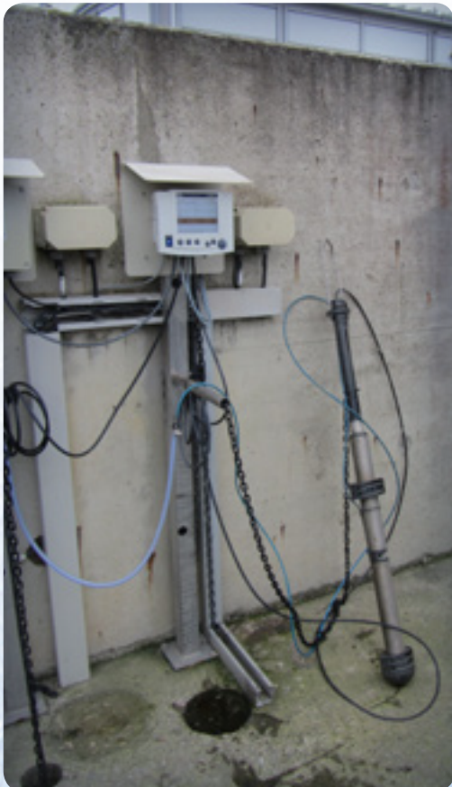
Installation der CarboVis® im Zulauf
